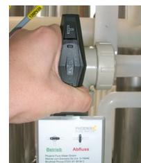
Válvula de três vias para a posição de drenagem.
