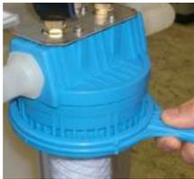
3. Abrir la carcasa del filtro con la llave de filtro en el sentido de las agujas del reloj.
