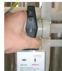
Válvula distribuidora de tres vías vaciado de permeado al desagüe
